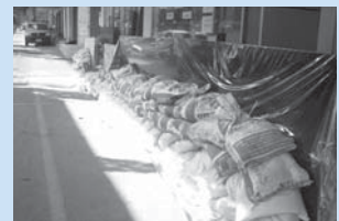
街の風景。水の浸入を防ぐために、土嚢が積まれている。
